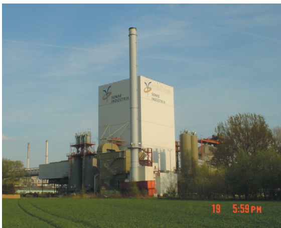
Das Biomassekraftwerk der Glunz/ GHP-Werke in Horn-Bad Meinberg (Kreis Höxter)
